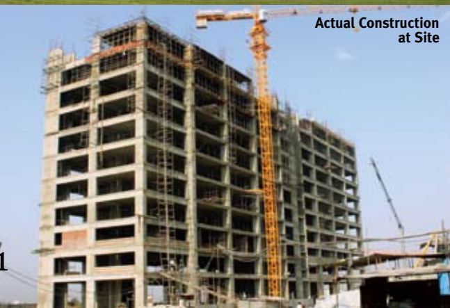
Actual Construction at Site
